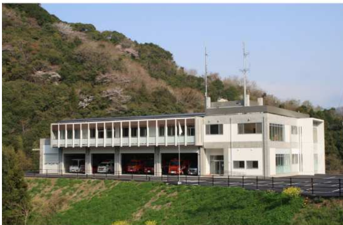
消防本部（署）庁舎
